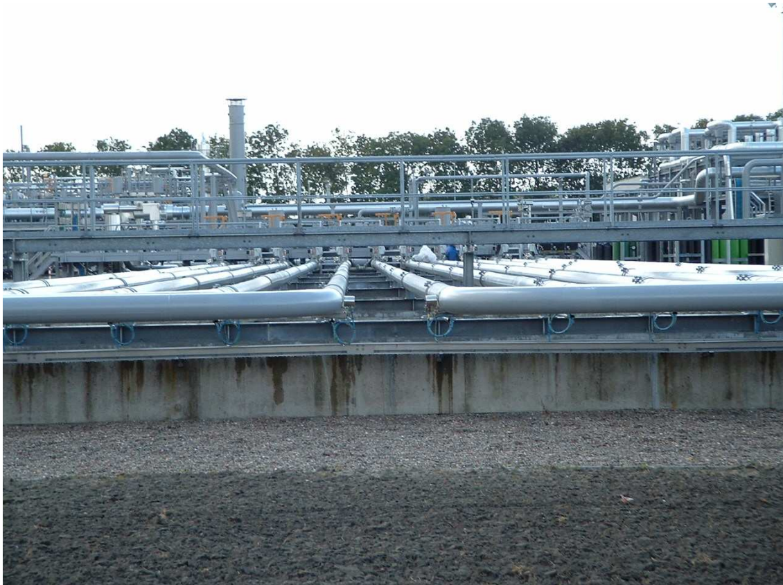
Installatie van sand monitoring detectors
